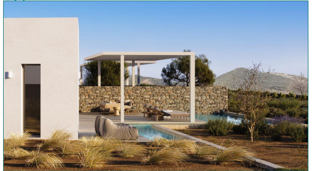
Εξωτερική Άποψη Κατοικίας Β – Κήπος και Πλάγια Όψη
